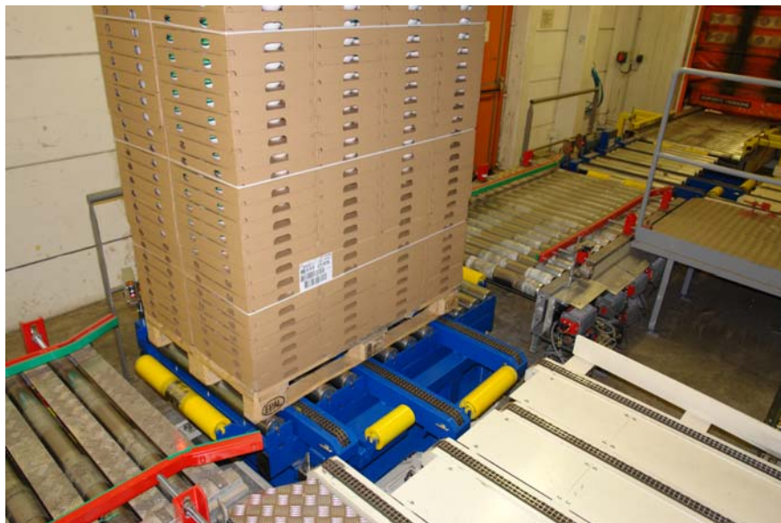
Photo : 8284 3 200 Légende : Palette sur table tournante transfert en entrée de tunnel
